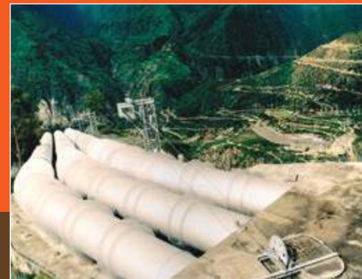
TUBERÍA A PRESIÓN
